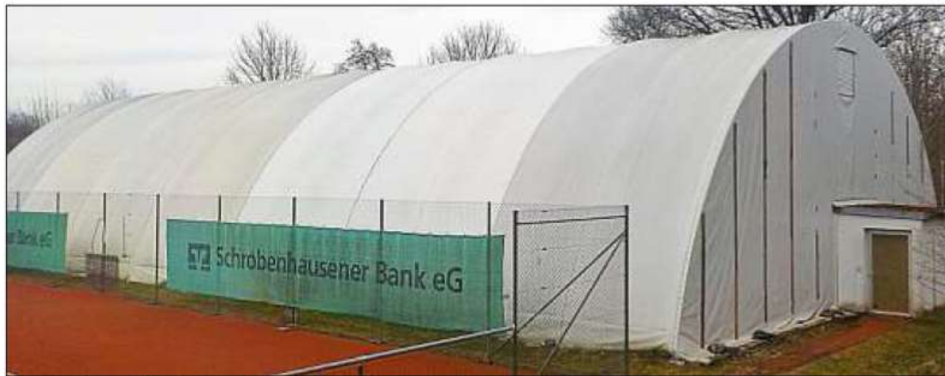
Die alte Tennishalle des TC Schrobenhausen soll abgerissen werden.
